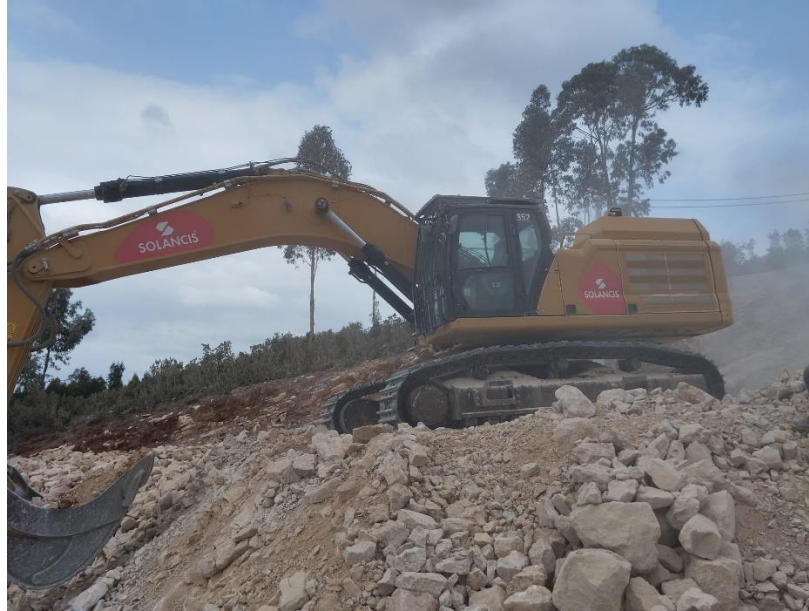
Escavadora de Rastos 352
